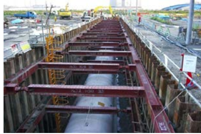
中央区晴海地区再開発事業に伴う下水道工事
