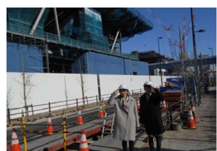
ただいまより、工事現場を見学します！敬礼
