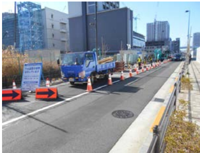
工事現場はきれいに整ってありました
