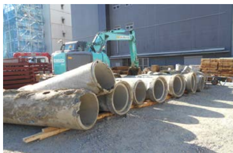
既設管の取り除いたものが並んでいます
