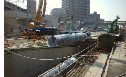
豊島区南長崎1丁目地内配水本管移設工事
