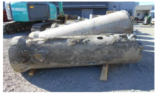
既設管はこんなに老朽化していました
