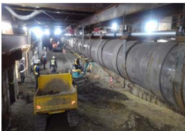
虎ノ門新駅設置に伴う下水道工事
