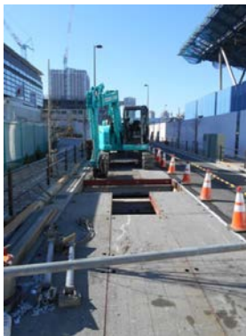
整理整頓された工事現場
