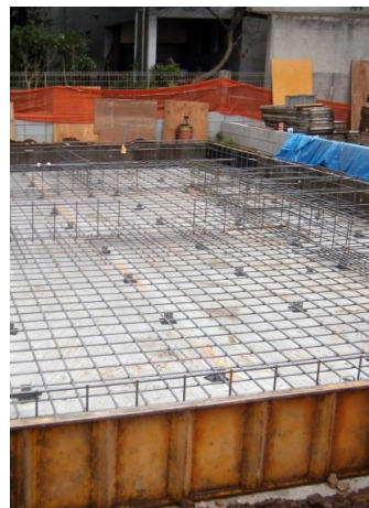
②高耐久・高強度を実現するコンクリートべた基礎
