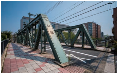
ほ 「平久橋」。鋼材を三角に組んで荷重に耐えるトラス橋。
